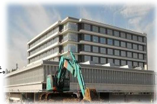
平成26年4月開院に向けて建設が進む 東千葉メディカルセンター
